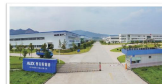
Shenzhen Base (Telecom)
