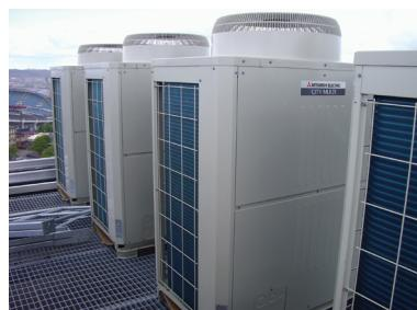
Выбор этой модификации оборудования обусловлен тем, что для эффективного функционирования отопительных конвекторов требуется теплоноситель с температурой +70°C, а для работы холодных потолков требуется хладоноситель с температурой +15°C.
