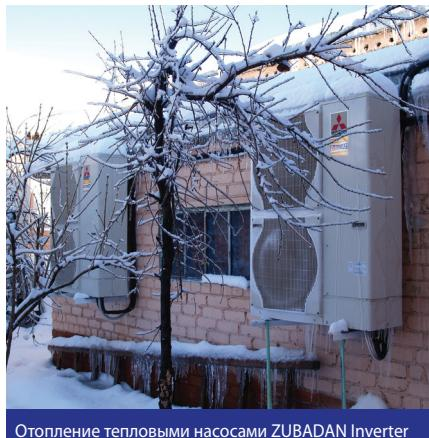
Отопление тепловыми насосами ZUBADAN Inverter
