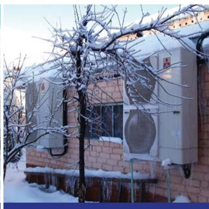
Отопление тепловыми насосами ZUBADAN Inverter
